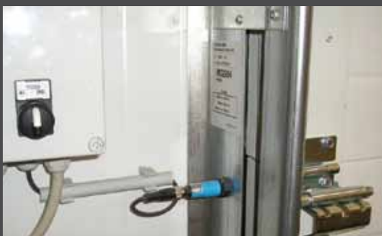
SENSOR PARA INTERCONEXÃO NIVELADORA-PORTA SENSOR PARA LA INTECONEXIÓN ENTRE TRAMO Y PUERTA
